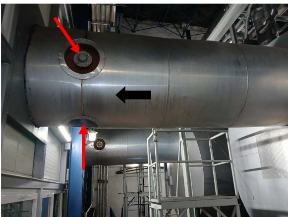
Obrázok č. 2 Pohľad na spalinovody z kotla K1, K2 a K3 a samostatné komíny KK1, KK2 a KK3)
