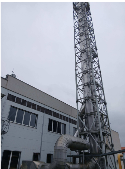
Obrázok č. 2 Pohľad na spalinovody z kotla K1, K2 a K3 a samostatné komíny KK1, KK2 a KK3)
